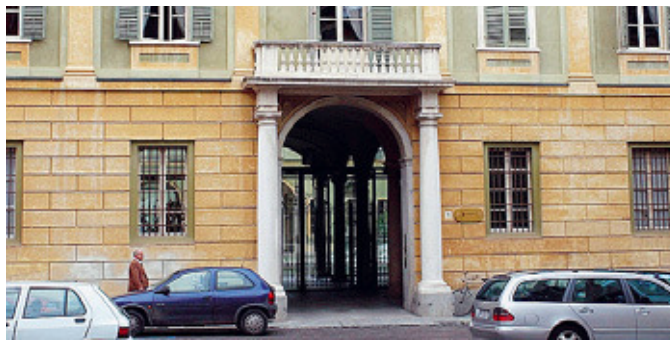
Banca Monte Trattativa «fiume» a Palazzo Sanvitale.
